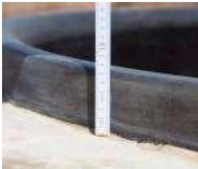
Der Schacht ist bis max. 75 mm unterhalb des Schachtröhrendes lagenweise gemäß DIN EN 1610 zu verfüllen und zu verdichten. Um das noch freiliegende Schachtröhrende ist eine Schutzschalung (z.B. stabile Folie oder Dachpappe) anzubringen und gemäß Vorgaben ein Auflager aus Ort beton C12/15 zu erstellen.
