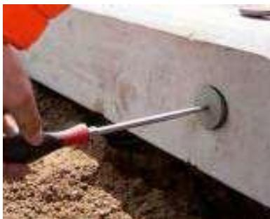
Die grauen Schutzkappen an den Außenkanten der Betonabdeckplatte sind mit einem geeigneten Schraubenzieher herauszuschrauben, um die M 16 Gewindegülen freizulegen.
