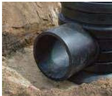
Je nach Ausführung sind die Rohrabschlüsse herzustellen. Hierzu ist ggf. das Spitzende des anzuschließenden Rohres zu säubern, anzufasen und gleichmäßig mit Gleitmittel zu versehen oder für Schweißverbindungen das Rohrende zu schälen und mit PE-Reiniger frei von Rückständen vorzubereiten. Schweißverbindungen können entweder mittels Heizwendel- oder Spiegelstumpforschweißungen ausgeführt werden.
