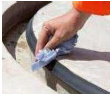
Die Dichtung der Betonabdeckplatte ist zu reinigen, auf Unversehrtheit und korrekten Sitz zu überprüfen. Die Dichtflächen **auf** der Schachtröhrinnenseite sind gleichermaßen zu reinigen und auf Beschädigungen zu überprüfen.
