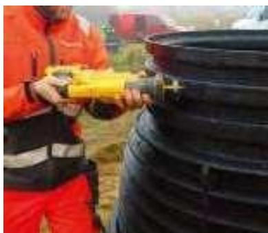
Eine Anpassung der Bauhöhe kann durch variable Schachtröhrenhöhen oder ein entsprechendes Einkürzen im Konushals realisiert werden. Das Kürzungsmaß beträgt je nach Abdeckung max. 100mm und ist durch Ablängen auf einer Welle realisierbar.
