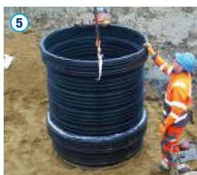
Danach ist das Schachtrohr ohne Ver- kanten auf den Schachtboden aufzu- setzen.
