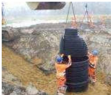
Der Schachtkonus ist abschließend analog zu den Schachtröhren auszurichten und ohne Verkanten aufzusetzen. Hierbei ist darauf zu achten, dass die Steiggangausrichtung eingehalten wird. Bei einer Montageunterstützung mit hydraulischem Gerät (Bagger o. ä.) ist auch hier zum Schutz der Schachtbauteile ein Kantholz oder eine entsprechende Platte zentral zur Schachtachse aufzulegen.
