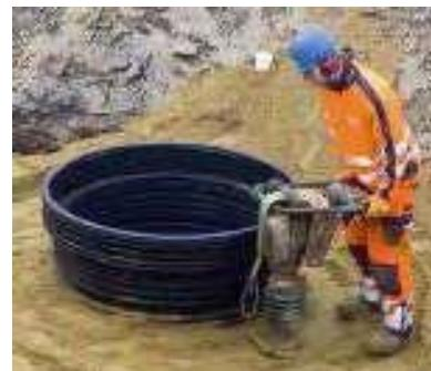
Der Schacht ist gemäß DIN EN 1610 in Lagen von max. 30cm zu verfüllen und mit entsprechendem Verdichtungsgerät verdichten. Die Procordichte bei der Verdichtung muss in Gebieten ohne Verkehrslast mindestens 95 %, in Gebieten mit PKW- oder Schwerlastverkehr mindestens 98 % betragen.
