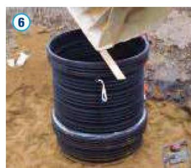
Bei einer Montageunterstützung mit hydraulischem Gerät ist zum Schutz der Schachtbauteile ein Kantholz oder eine entsprechende Platte zentral zur Schachtachse aufzulegen. Eine Bauteilüberlastung ist in jedem Fall auszuschließen.
