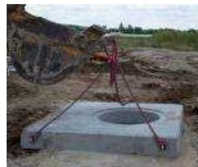
Die Betonabdeckplatte ist waagerecht auf das von einem ebenen Betonauf lager umgebene Schachtröhrende abzusetzen. Gemäß Vorgaben ist hierbei eine Setzungsfuge von min. 20 mm und max. 50mm zu berücksichtigen. Für einen Lastabtrag in den umliegenden Boden ist bauseits Sorge zu tragen. Die Abdeckung ist abschließend unter Verwendung von Ausgleichsmörtel auf die Abdeckplatte zu setzen. Punktlasten und Hohlräume sind hierbei grundsätzlich zu vermeiden.
