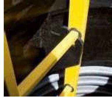
Bei Schachtausführungen mit werkseitig vormontierter Leiteraufnahme ist zunächst die Position der Steigleiter im Hinblick auf die Auftrittsfläche im Schachtboden zu prüfen und ggf. zu korrigieren. Die Leiter ist von oben durch den Konushals in den fertig eingebauten Schacht einzulassen.
