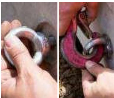
In die Hülsen sind passende Gewindeösen M16 sicher einzuschauben. Die Betonabdeckplatte ist dann mit einer geeigneten Kette an allen Ösen sicher einzuhängen.
