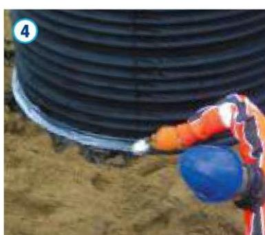
Bevor das Schachtrohr auf den Schachtboden aufgesetzt werden kann, sind die Dichtelemente nochmals auf ihren korrekten Sitz zu überprüfen und alle Dichtflächen ggf. zu reinigen. Alle Dichtungen und Dichtflächen sind dann gleichmäßig und umlaufend mit Gleitmittel zu versehen.
