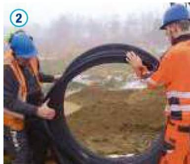
Vor dem Einbau der Schächte sind zu- dem alle Bauteile auf Beschädigungen und Verunreinigungen zu überprüfen. Verunreinigte Dichtelemente und Schachtkomponenten sind zu säubern. Beschädigte Bauteile sind gegebenen- falls auszutauschen. Die Dichtelemente sind auf korrekten Sitz und Unversehrt- heit zu überprüfen.
