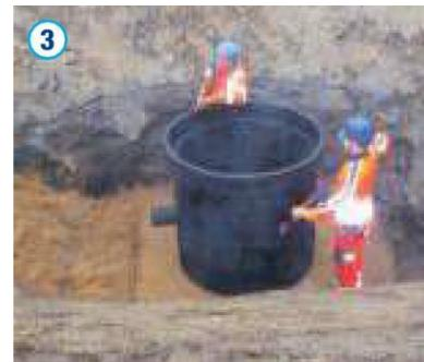
Der Schachtboden ist in den Graben abzulassen, gemäß den Planungsvor- gaben zur Leitungsführung auszurichten und schließlich entsprechend dem erforderlichen Gefälle einzubetten. Hierbei ist auf den Höhenunterschied zwischen Bodenplatte und Rohr- anschluss zu achten.
