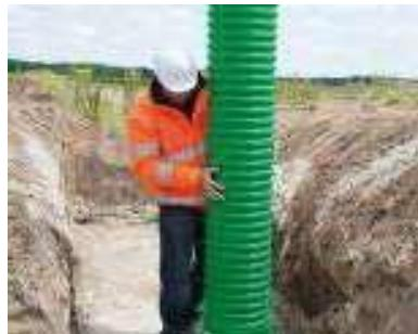
Das Schachtrohr mit eingelegter Dichtung ist auf den Schachtboden zu setzen und bis zum Anschlag einzustecken.
