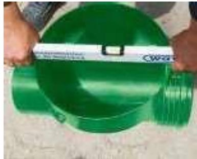
Der Schachtboden ist gemäß den Planungsvorgaben auszurichten. Hierbei ist der Schachtboden entsprechend dem erforderlichen Gefälle einzubetten. Zusätzlich ist ggf. darauf zu achten, dass die Schachtrohrmuffe senkrecht zur Rohrachse steht. Bei Bedarf kann der Schachtboden auch gemäß der Rohrauflagefläche bis zur Muffe in die Bettung eingelassen werden.
