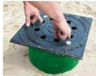
Das Auflager für die Teleskopabdeckung ist entsprechend der Belastungsklasse (SLW 30 / SLW 60) aus einer 250mm breiten und min. 150mm hohen Ort betonschicht herzustellen und gleichmäßig um das Schachtrohr/ Teleskoprohr auszuführen. Je nach Belastungsklasse kann ggf. ein größeres Auflager erforderlich werden. Die Abdeckung ist ohne Punktlasten und Hohlräume in das Auflager einzubetten.
