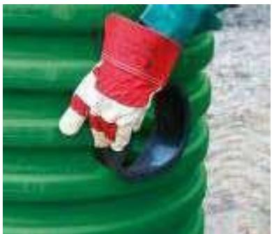
Daraufhin ist die Gummimanschette des Tegra 600 Anschluss-Stücks aus PP zunächst ohne Gleitmittel in die gebohrte Öffnung einzulegen. Erst nach erfolgreicher Montage der Gummimanschette ist diese an der Innenseite gleichmäßig mit Gleitmittel zu versehen. Es ist darauf zu achten, dass das Dichtelement an der dafür vorgesehenen Position verbleibt.
