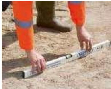
Die Aufstandsfläche des Schachtbodens ist gemäß DIN EN 1610 „Bettung Typ 1“ auszuführen. Zur Vermeidung von Punktlasten oder Hohlräumen ist die Aufstandsfläche entsprechend der Schachtbodenunterseite vorzuformen oder bei der Verfüllung auf eine entsprechende Unterfütterung zu achten. Alle Komponenten sind vor dem Einbau zu überprüfen.
