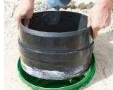
Bei Bedarf können Schachtröhre auch verlängert werden. Hierzu ist eine entsprechende Schachtröhreverlängerung einzusetzen. Diese ist beidseitig am Spitzende mit Gleitmittel zu versehen. Die Schachtröhrenden zur Verlängerung sind jeweils im letzten Wellental der Schachtröhrinnenseite mit einem Dichtelement zu versehen. Dann können die Komponenten zusammengesteckt werden.
