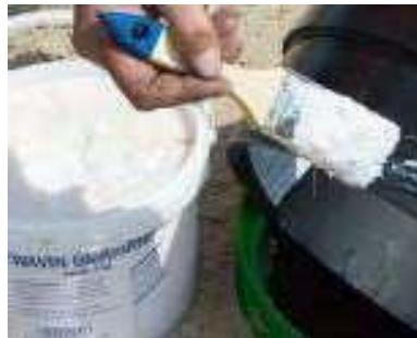
Das Teleskoprohr ist ggf. zu säubern und gleichmäßig umlaufend mit Gleitmittel zu versehen. Bei Bedarf kann das Teleskoprohr auch gekürzt werden. Danach ist es zu entgraten und erneut anzufasen.
