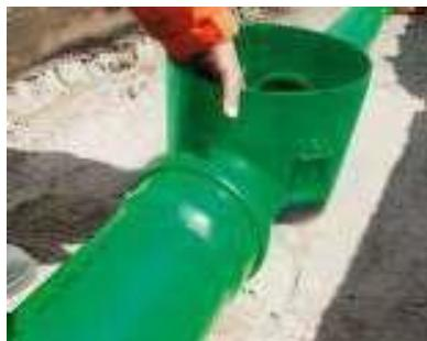
Das anzuschließende Rohr ist dann gemäß Herstellerangaben mit der Muffe auf das Spitzende des Schachtbodens zu stecken. Bei den Zuläufen ist das Spitzende des anzuschließenden Rohres anzufasen, zu reinigen, mit Gleitmittel zu versehen und in die Muffe des Schachtbodens bis zum Anschlag einzustecken.
