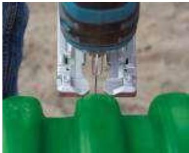
Bei Bedarf kann das Schachtrohr entsprechend der erforderlichen Einbautiefe abgelängt werden. Hierzu ist das Schachtrohr mit Hilfe einer Säge auf einer Außenwelle (äußerster Profilpunkt) zu durchtrennen (vgl. Einbautiefen- matrix Seite 143).
