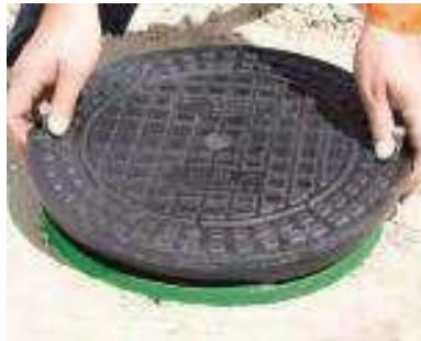
Dann sind die Außensechskantschrauben (M 8) der Abdeckung mit einem Innensechskantschlüssel (13 mm) zunächst so weit zu lösen, dass die Abdeckung auf das Schachtrohrende aufgesetzt werden kann.
