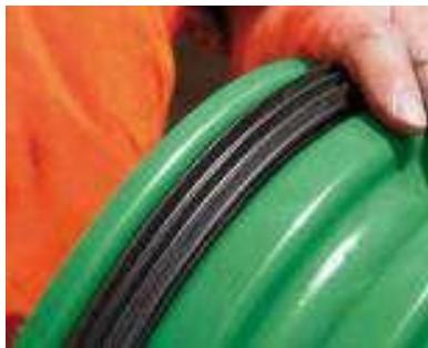
Das Dichtelement ist im ersten Tal (zwischen der ersten und zweiten Welle) zu montieren. Hierbei ist auf die korrekte Richtung und den richtigen Sitz mittig im Tal zu achten.
