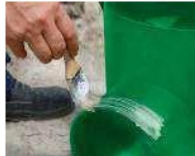
Für den Anschluss der glattwandigen genormten Rohre ist das Spitzende am Auslauf zu reinigen und auf der Außenseite gleichmäßig mit Gleitmittel zu versehen.
