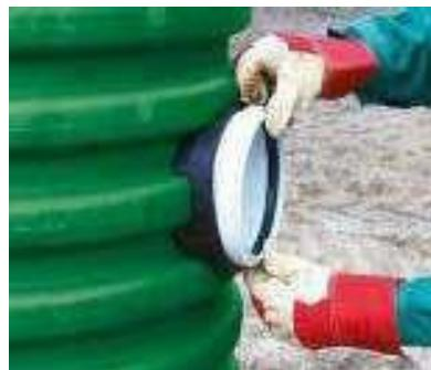
Anschließend ist das Anschluss-Stück DN/OD 110 bzw. DN/OD 160 in die Gummimanschette einzustecken. Das Spitzende des anzuschließenden Rohres ist gemäß Herstellerangaben anzufasen, mit Gleitmittel zu versehen und in das Anschluss-Stück einzustecken. Hierbei ist darauf zu achten, dass das Anschluss-Stück frei von Verunreinigungen ist.
