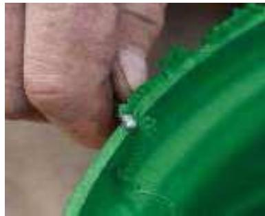
Vor dem Einlegen der Dichtelemente sind Unebenheiten an der Schachtrohrtrennkante zu entfernen und das Schachtrohr umlaufend zu entgraten.
