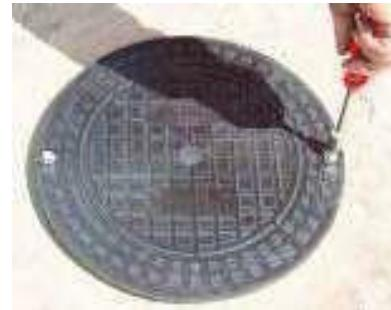
Die Außensechskantschrauben sind nach dem Aufsetzen der Abdeckung im Schachtrohr zu verschrauben. Hierbei ist die Abdeckung auf das Schachtrohr zu drücken oder zu fixieren.
