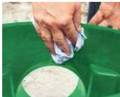
Vor dem weiteren Einbau der Schächte sind alle Bauteile nochmals auf Beschädigungen und Verunreinigungen zu überprüfen. Verunreinigte Dichtelemente und Schachtkomponenten sind zu säubern. Beschädigte Bauteile sind gegebenenfalls auszutauschen und Dichtelemente auf korrekten Sitz zu überprüfen.
