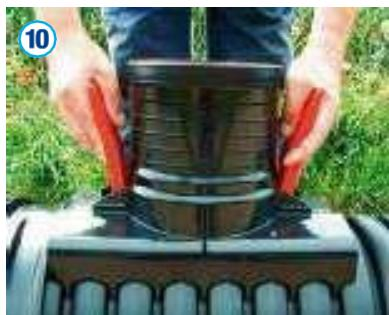
Es ist sicherzustellen, dass der X-Stream Sattel frei von Schmutz ist. Beim Einsetzen ist kein Gleitmittel zu verwenden. Der X-Stream Sattel ist so in die Bohrung einzusetzen, dass das Profil des Sattels in die Wellen des X-Stream Rohres greift. Durch Hineinfassen in den Sattel ist zu überprüfen, ob die Dichtung gleichmäßig in das X-Stream Rohr hineinragt.
