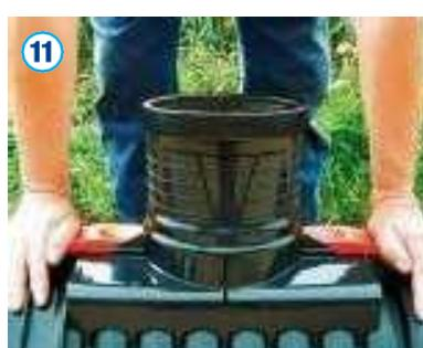
Beide Hebel sind synchron bis zum Einrasten herunterzudrücken, damit der Sattel nicht verkantet. Durch das Umlegen der Montagehebel wird der Kern nach oben gezogen und die integrierte Dichtung legt sich umlaufend dicht an die Rohrinnenwand an. Es ist zu kontrollieren, ob sich die Dichtung gleichmäßig an das Hauptrohr angepresst hat.
