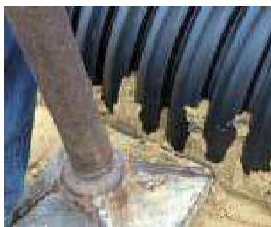
Die Bettung, Seitenverfüllung, Überdeckung und Hauptverfüllung sind gemäß DIN EN 1610 auszuführen. Die Seitenverfüllung ist insbesondere im Kämpferbereich besonders sorgfältig mit leichtem Verdichtungsgerät durchzuführen.
