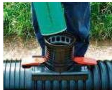
Nach der Montage des Sattels ist das anzuschließende KG oder KG 2000 Rohr in den Sattel einzustecken. Hierfür ist das Spitzende des Rohres anzufassen, zu entgraten und gleichmäßig mit Gleitmittel zu versehen.
