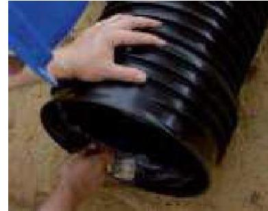
Das Gleitmittel ist gleichmäßig auf die Muffeninnenfläche aufzutragen, bevor das Spitzende mit eingelegter Dichtung bis zum Anschlag in die Muffe eingeschoben werden kann. Ein Zurückziehen des Rohres ist nicht erforderlich. Geringe Richtungsänderungen sind durch eine Abwinkelung von max. 0,5° in der Muffe realisierbar. Dies entspricht 5cm Auslenkung auf 5m.
