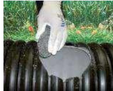
Die Bohrung ist mit z.B. feinem Schleifpapier (beiliegend) zu entgraten. Ein Messer zum Entgraten ist nicht zulässig, da dies die Abdichtungsfläche beschädigen könnte und die Dichtigkeit dann nicht mehr gewährleistet werden kann. Es ist darauf zu achten, dass die Dichtfläche frei von Unebenheiten ist und der Durchmesser nicht vergrößert wird.
