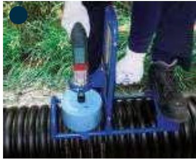
Vor der Verwendung des X-Stream Sattels ist dieser auf Verunreinigungen und Beschädigungen zu überprüfen und ggf. auszutauschen oder zu säubern. Die Sattelnennweite muss zudem mit der Dimension der anzubohrenden Leitung übereinstimmen. Der Kronenbohrer ist vor dem Anbohrvorgang optisch auf mechanische Beschädigungen zu überprüfen.
