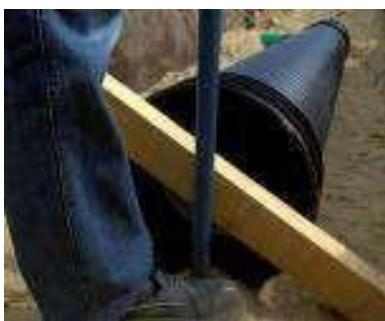
Rohre kleiner Nennweiten sind leicht von Hand zusammenzuschieben; für größere Nennweiten sind ggf. geeignete Hilfsmittel zu verwenden. Ein Zusammenschieben mit z. B. einem Baggerlöffel ist aufgrund unkontrollierter Kraftentfaltung und Rohrbeschädigungen nicht zulässig. Die Lage des Rohres ist zu überprüfen und nach Herstellen der Verbindung evtl. entsprechend zu korrigieren.
