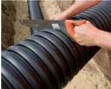
Wavin X-Stream Rohre können bausseits auf die erforderliche Baulänge gekürzt werden. Hierzu ist das Rohr mit einer feinzahnigen Säge senkrecht zwischen zwei Wellen abzulängen. Grate und Unebenheiten sind mit einem geeigneten Werkzeug, z.B. grober Feile oder Schaber, zu entfernen. Ein Anfasen des Rohres ist nicht erforderlich. Formstücke dürfen nicht gekürzt werden.
