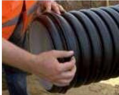
Das Spitzende inklusive Wellen sowie die Innenfläche der Muffe müssen sauber und frei von Beschädigungen sein. Andernfalls ist das Rohr zu reinigen oder ggf. auszutauschen. Der Dichtring ist im ersten Wellental einzulegen. Der ordnungsgemäße Sitz des Dichtrings am Rohrumfang ist zu überprüfen. Verdrehungen der Dichtung sind nicht zulässig.
