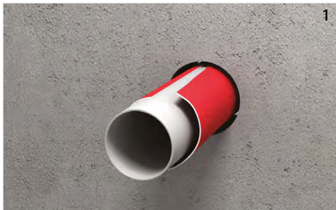
Rohrleitung (ggf. mit Schallschutzschlauch) installieren.
